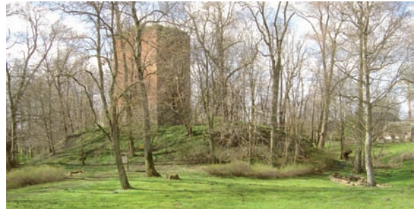
Abb. 1 - Nehringen, Turmhügel mit Blick aus östlicher Richtung.
