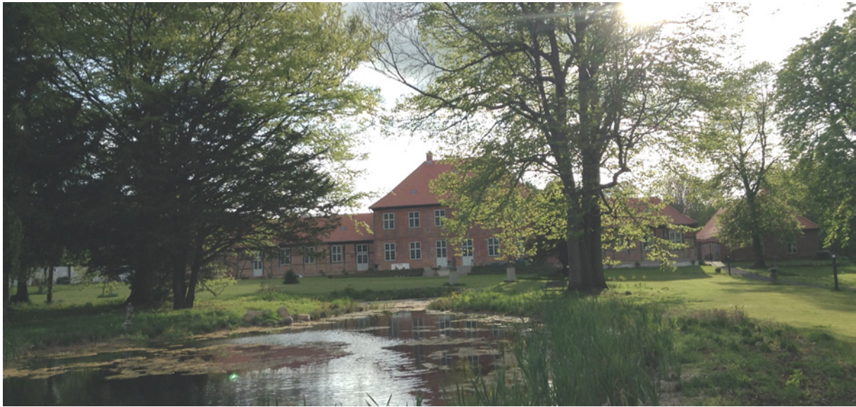
Abb. 3: Falkenhagen. Blick durch den Park auf das Haupthaus.
